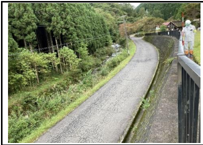
写真18 擁壁天端の状況
