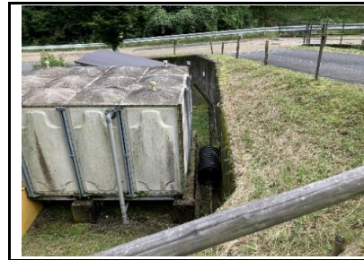
写真3 南側境界付近の状況
