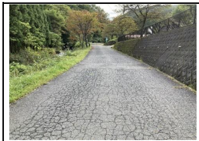
写真21 路面の亀裂
