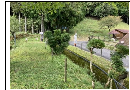
写真4 南西側境界付近の状況
