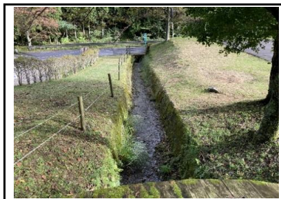
写真9 中央部水路の状況
