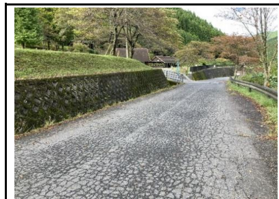
写真23 路面の亀裂
