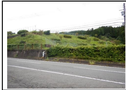
写真18 東側境界付近の状況
