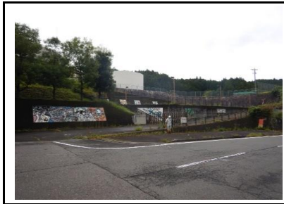
写真2 中央部境界付近の状況
