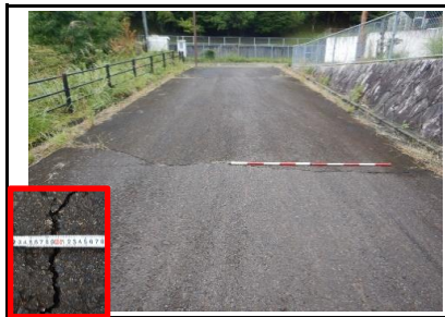
写真21 路面のクラック
