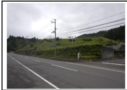
写真17 東側境界付近の状況
