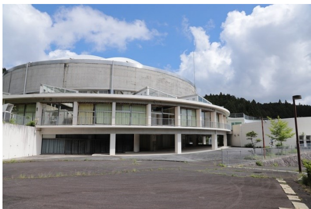
西方面 進入口
