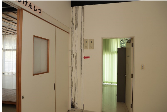
採光窓や排煙窓の継ぎ目が劣化し、雨漏りが発生している
