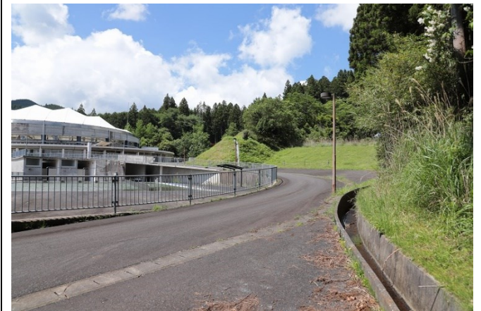
東方面 国道からの進入路③
