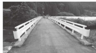
▲橋梁長寿命化修繕事業(土屋原: 郷山橋)
