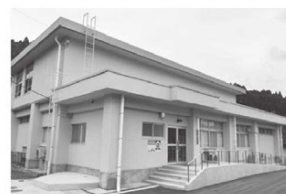
▲菅野体育館・公民館耐震工事
