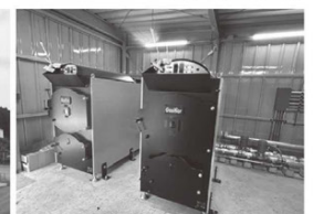
▲薪ボイラー整備
