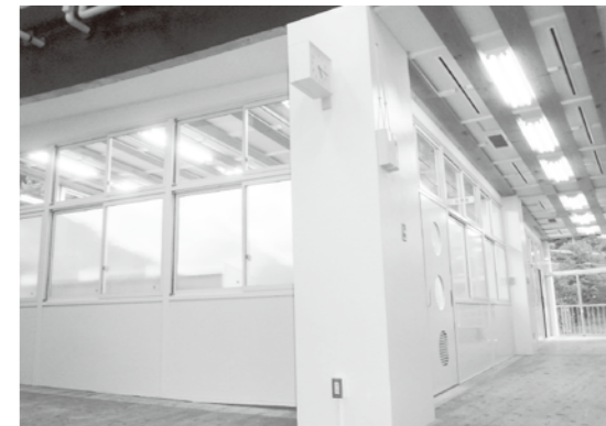
御杖小学校教室間仕切り工事
