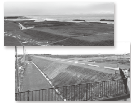
津波被害により嵩上げされた道路(土地)
