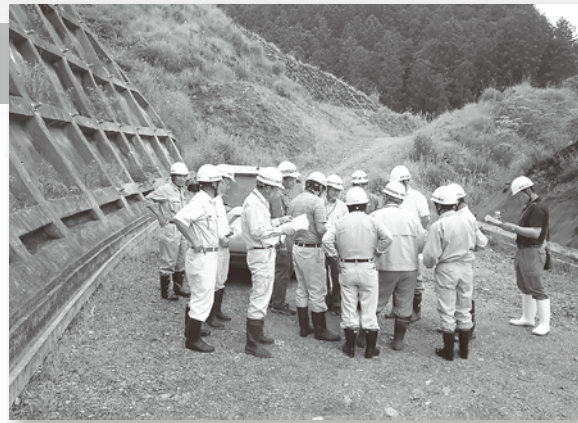
(仁柿峠 改良現場視察)
