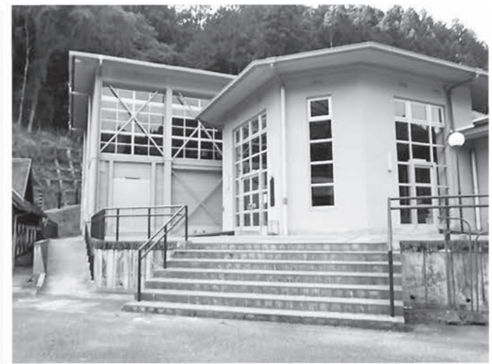
平成30年度 耐震改修事業・ 桃俣多目的研修センター
